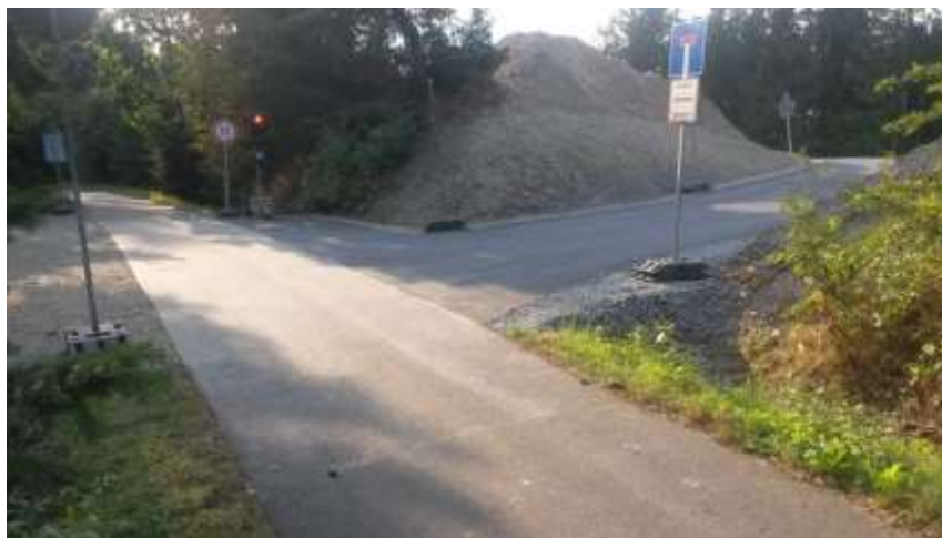
Bild 6 Ampelregelung bis „Bahnhof Möschlitz“, rechts Zufahrt zur Schleizleite
