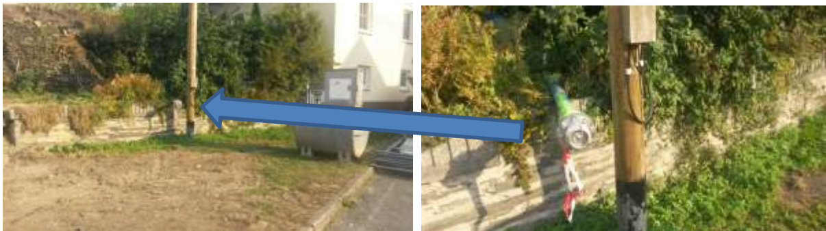
Zuleitung „Am Bach“ Bilder 1 und 2
